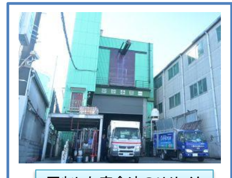
回収した廃食油のリサイクル施設
