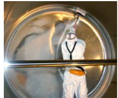
金属母材のタンク内部へのフッ素樹脂シートライニング加工
