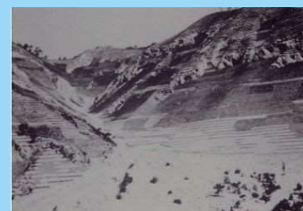
明治・大正時代の山腹工事
