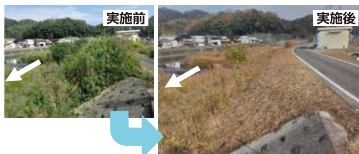
河川堤防の点検前除草(佐用町)
