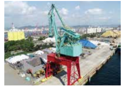
姫路港須加地区 県営クレーン(姫路市)
