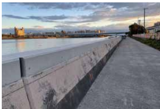
尼崎西宮芦屋港海岸 芦屋浜地区 防潮堤嵩上げ(芦屋市)
