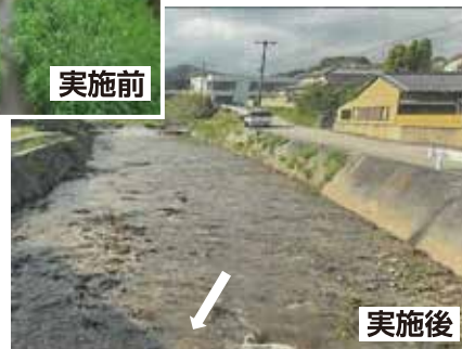
生穂川 堆積土砂撤去(淡路市)
