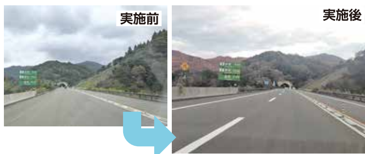
道路区画線の引き直し(新温泉町)
