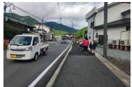
国道429号 千草I(宍粟市)
