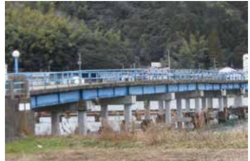
県道 豊岡竹野線 城崎大橋 (豊岡市)
