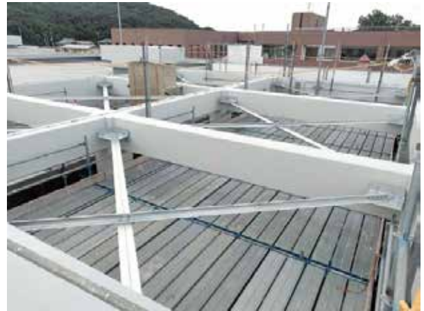
加古川上流浄化センター[小野市] 受変電棟耐震対策
