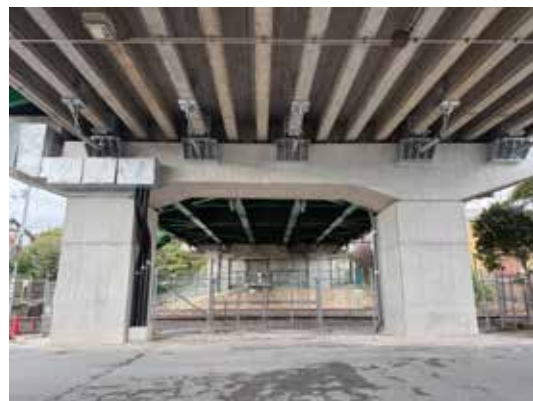
県道 曾根阿弥陀線 庵ノ下橋 落橋防止装置・橋脚補強(高砂市)
