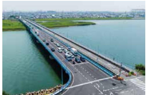
県道 明石高砂線 相生橋西詰交差点 (高砂市)
