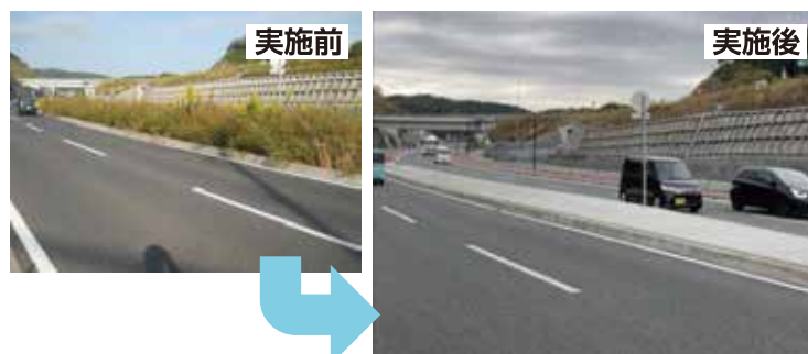
中央分離帯の張りコン(川西市)
