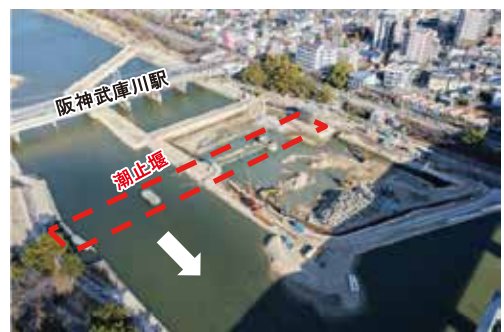
武庫川 潮止堰撤去(西宮市等)
