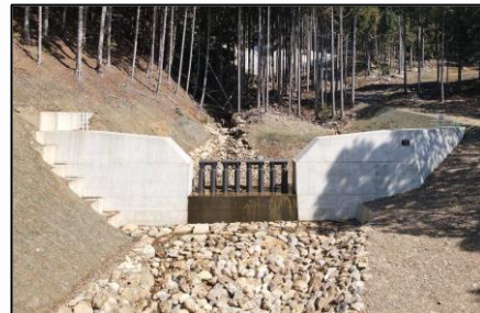
流木捕捉型治山ダム(丹波市)
