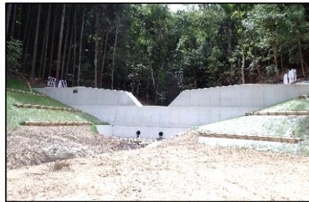
流木・土砂流出防止対策(加西市)
