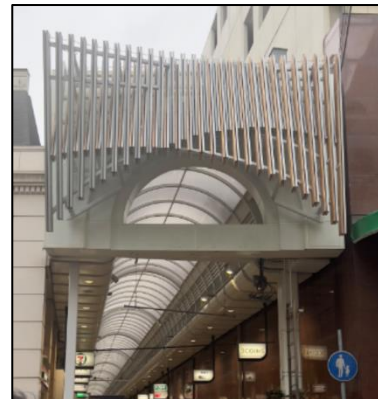
三宮本通商店街ファサード(神戸市) (②屋外木質化)
