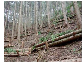
緊急防災林整備 (斜面对策)
