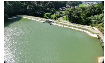
改修したため池 (丹波篠山市)
