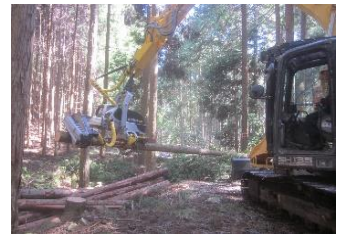
高性能林業機械による 木材の搬出
