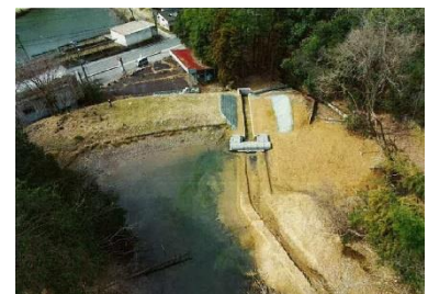
ため池廃止（養父市）
