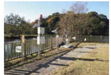
ICT の活用によるため池遠隔監視 (淡路市)
