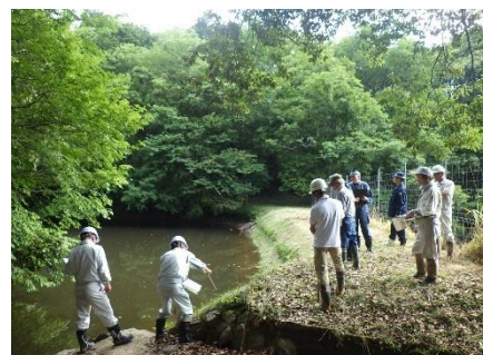
ため池の防災パトロール
