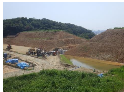
改修中のため池（姫路市相合池）
