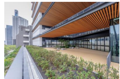
公共施設内外装（中央区）
