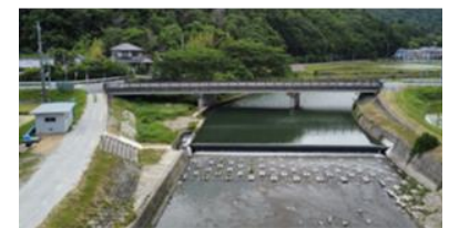
改修されたゴム引布製起伏堰 (三田市)
