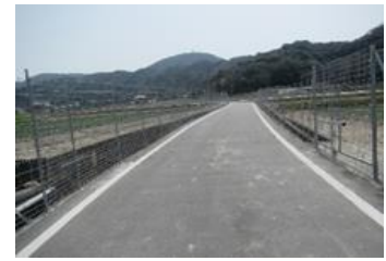
獣害防止柵の設置
