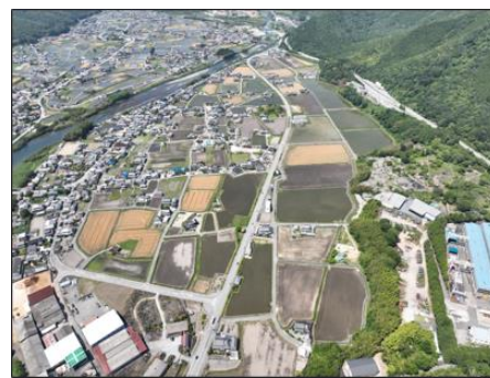
農地整備施工後（市川町屋形地区）
