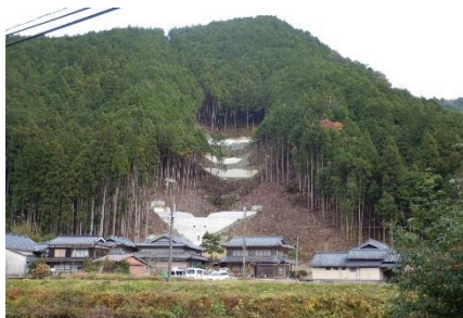
治山ダム等の整備（神河町新田地区）
