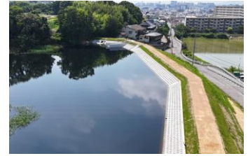
改修されたため池（明石市）
