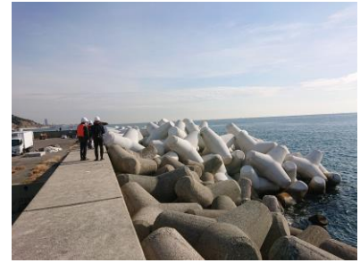
嵩上げされた消波ブロック (垂水区)
