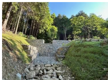
緊急防災林整備(溪流対策)で整備した簡易防災施設(佐用町)
