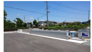
防潮ゲートの改修（播磨町）
