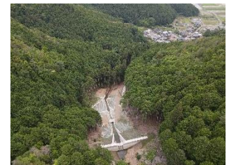
集落への土砂の流出を防ぐ 治山ダム(丹波市)
