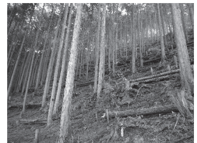
伐採木を利用した土留工（丹波市）
