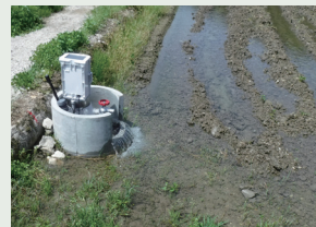
用水路を管路化し遠隔操作型自動給水栓を設置(丹波市)
