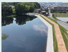
改修されたため池(明石市)
