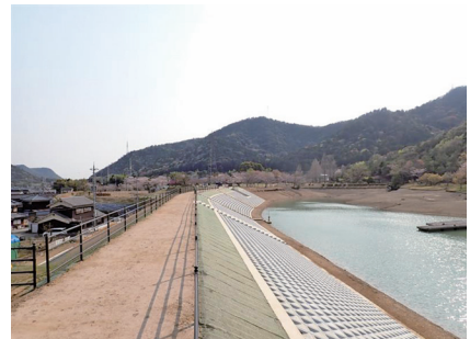
ため池防災工事の実施(西脇市)
