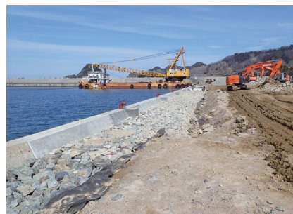
香住漁港 岸壁耐震化施工状況
