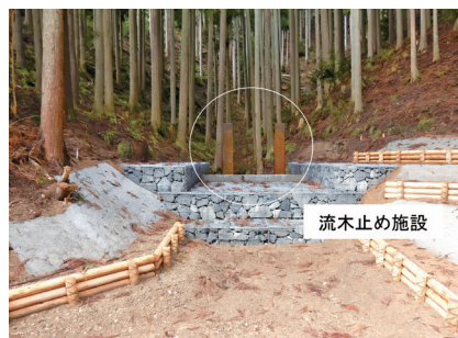
簡易流木止め施設と災害緩衝林の整備(市川町)
