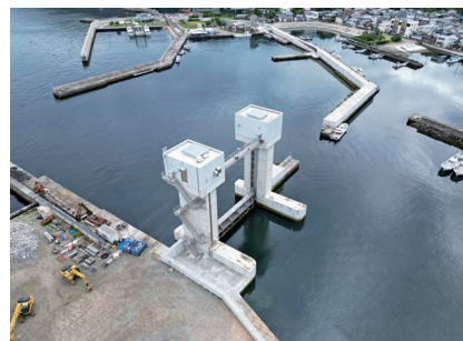
沼島漁港 本港地区港口水門施工状況
