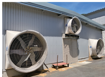
牛舎に設置された大型送風装置(赤穂市)
