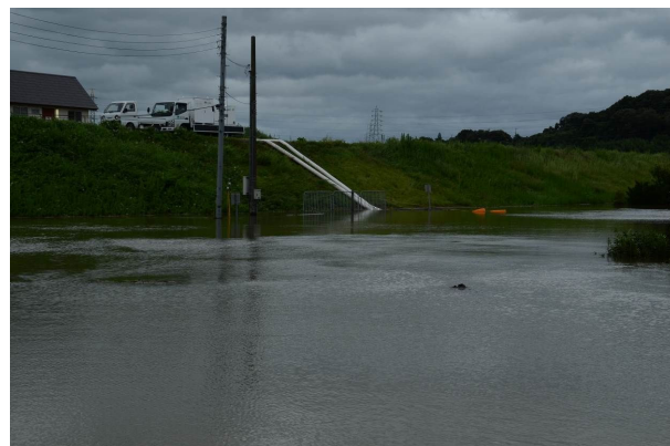
排水ポンプパッケージ車稼働状況
