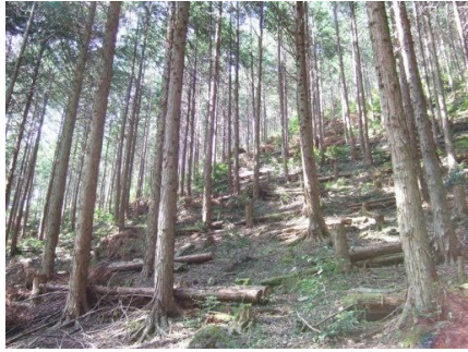
緊急防災林整備（土留工）
