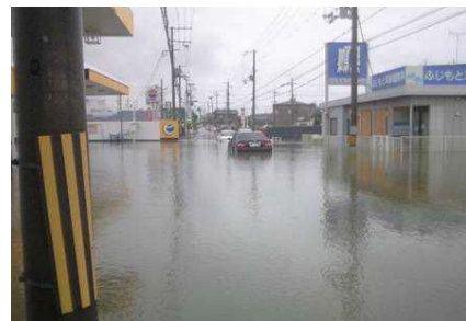
小原宝殿停車場線の出水状況
