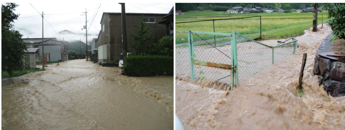
平成 25 年 9 月豪雨の浸水状況
