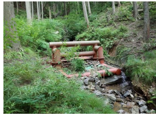
緊急防災林整備 (簡易流木止め工)
