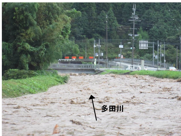
平成 25 年 9 月豪雨増水状況（多田川下流部：杉原川との合流点付近）
