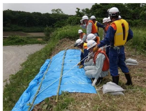
シート張り工法
