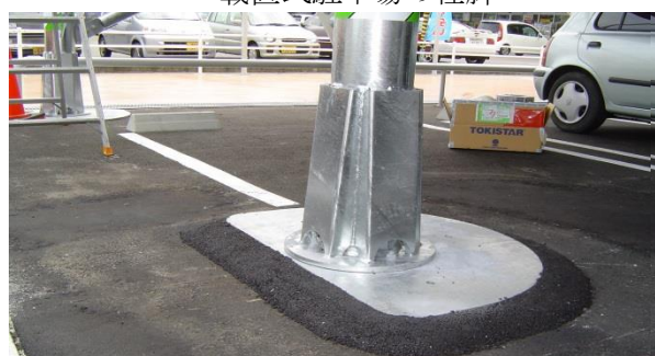
載置式駐車場の柱脚
