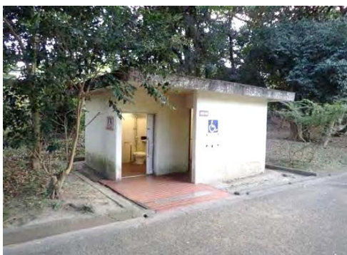
撤去・新設予定のトイレ
