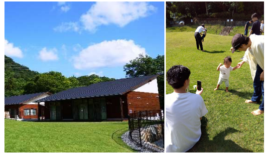
パークセンターの改修（甲山森林公園）
