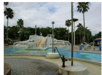
ウォーターランドの改修 (西猪名公園)
