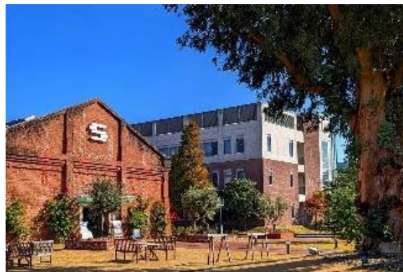
No1 洲本市新都心地区(洲本市) (工場跡地等を利活用した新市街地)
