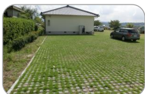
コンクリートブロックを用いた事例
