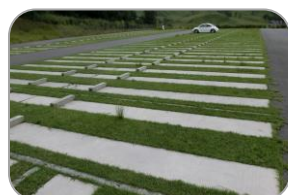
車輪部を補強している事例
