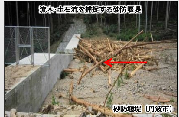
流木・土石流を捕捉する砂防堰堤
