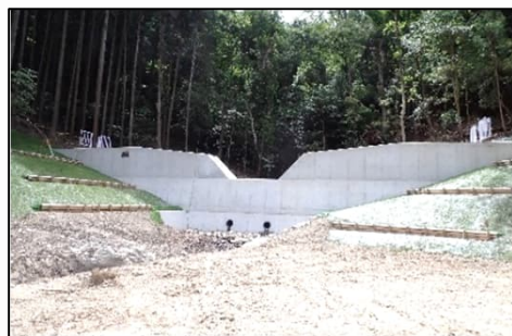
流木・土砂流出防止対策(加西市)
