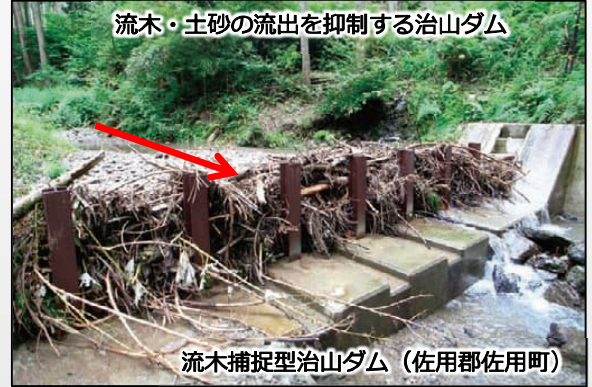
流木・土石流を捕捉する砂防堰堤
