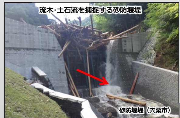
流木・土砂の流出を抑制する治山ダム
