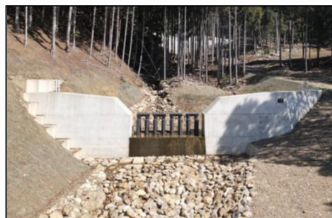
流木捕捉型治山ダム(丹波市)
