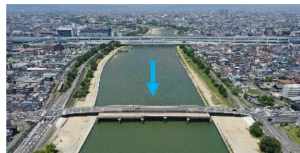
南武橋新橋完成
