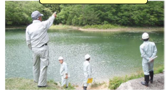
ため池定期点検の実施
