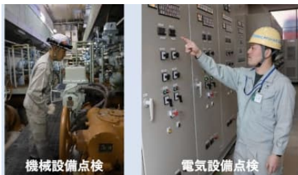
配水池設備点検状況 (神戸市)
