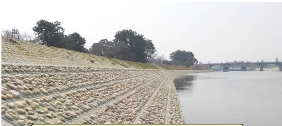
仁川合流点に堆積していた自然石を利用し、護岸を整備
