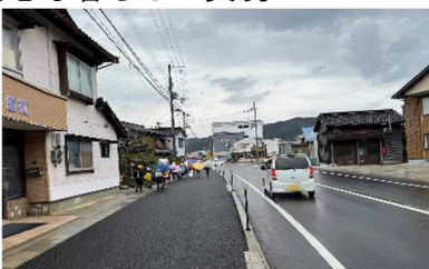
県道 香住村岡線(香美町) [歩道整備]
