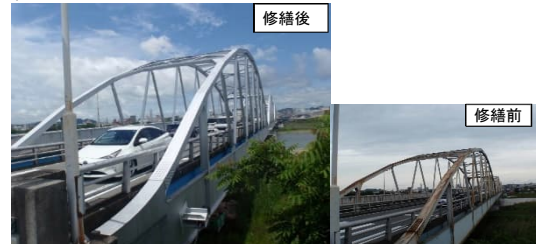
県道 白浜姫路停車場線 阿保橋 (姫路市) [橋梁修繕]
