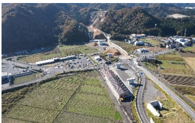
山陰近畿自動車道 浜坂道路Ⅱ期 新温泉浜坂IC(新温泉町) [高規格道路]
