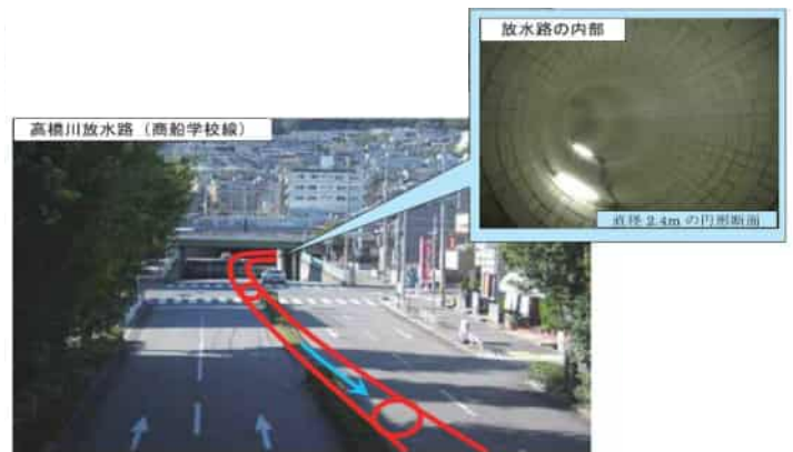
図 2.1.2 高橋川放水路
