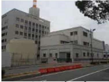
中突堤ポンプ
