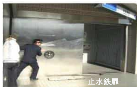
図 3.3.19 止水板、止水鉄扉の設置（神戸市営地下鉄）
