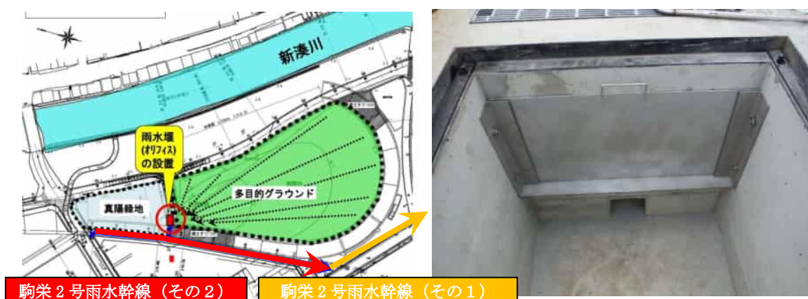
図 2.2.2 真陽南さくらグラウンドにおける流出調整機能施設（オリフィス）の整備
