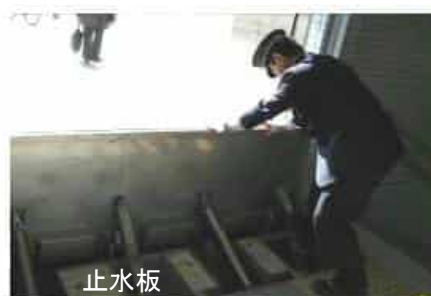
図 3.3.19 止水板、止水鉄扉の設置（神戸市営地下鉄）
