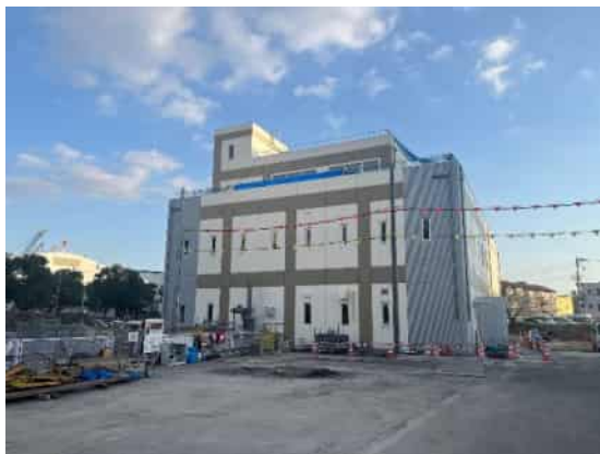
雨水ポンプ場
