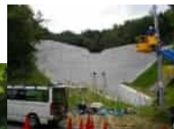
東が辻2号 砂防えん堤
