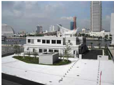
京橋ポンプ場
