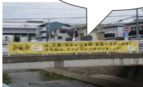
注意喚起のための回転灯・電光掲示板 等の整備
