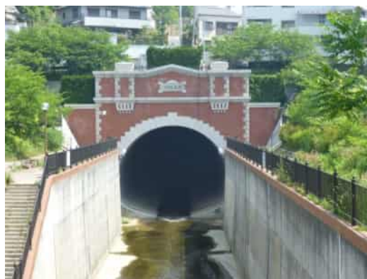
図 2.1.10 湊川トンネル（新湊川） 【吐口側】
