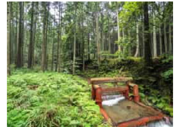
簡易流木止め施設
