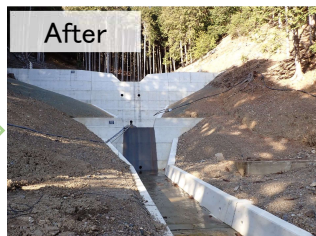
治山ダムの整備 (丹波市春日町稲塚地区)
