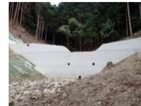
治山ダムの整備
