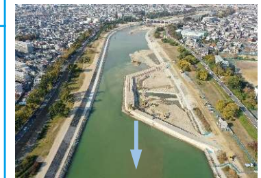
武庫川 河川改修(1号床止撤去)
