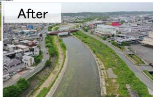
明石川(神戸市) 堆積土砂撤去
