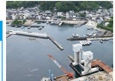
沼島漁港 津波対策(水門等整備)
