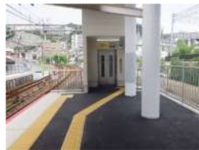
鉄道駅におけるエレベーター設置
