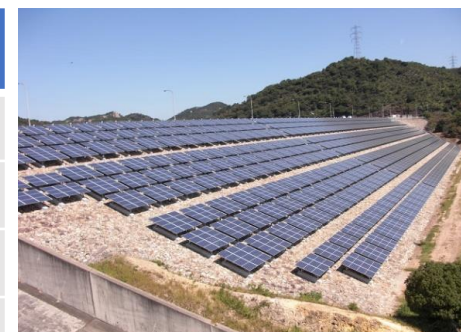
【権現ダム堤体法面】
