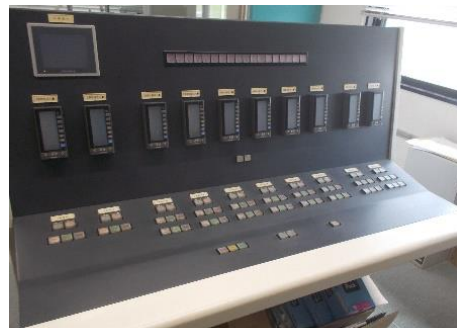
【三田浄水場 中央監視制御設備更新工事】
