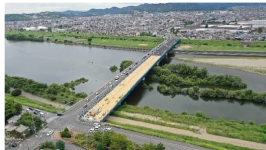
国道2号(加古川橋工区)の整備
