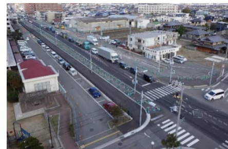
国道2号(和坂拡幅)の整備
