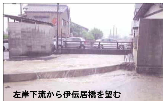
図 1.15 屈曲部からの越水状況（平成 24 年）
