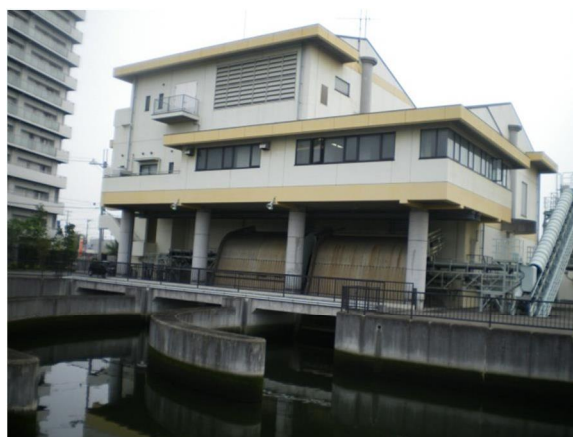
野田川排水機場
